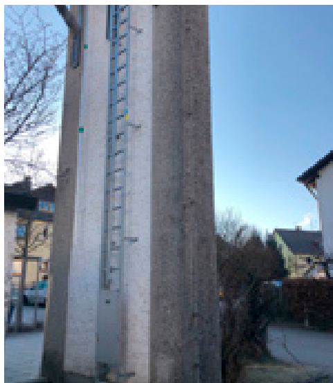
Der Anfang der neuen Leiter am Kirchturm zur Wartung der Glocken.
