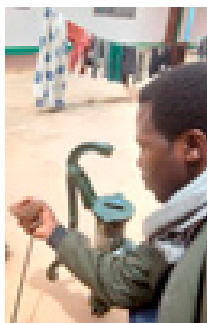
Vito, ein junger Mann aus der Gemeinde, ist ein geschickter Handwerker. Er hat mit den Ersatzteilen aus dem Container sofort die defekten Pumpen im Hof repariert.
