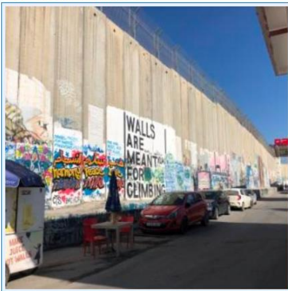
70 Mauer innerhalb von Bethlehem
