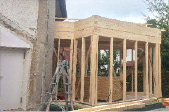
Die neue Sakristei entsteht, nicht in Stein, sondern Leichtbauweise, wieder an der Stelle, an der die erste Sakristei von 1955 stand.
