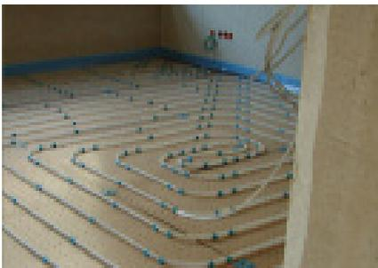
Das Jahr 2016 war von Mitte Januar an geprägt vom Innenausbau. Als Beispiel ist hier die Verlegung der Fußbodenheizung zu sehen. Die Firmen, das Büro meck architekten und alle Beteiligten sorgten dafür, dass der Zeitplan stets eingehalten werden konnte!
